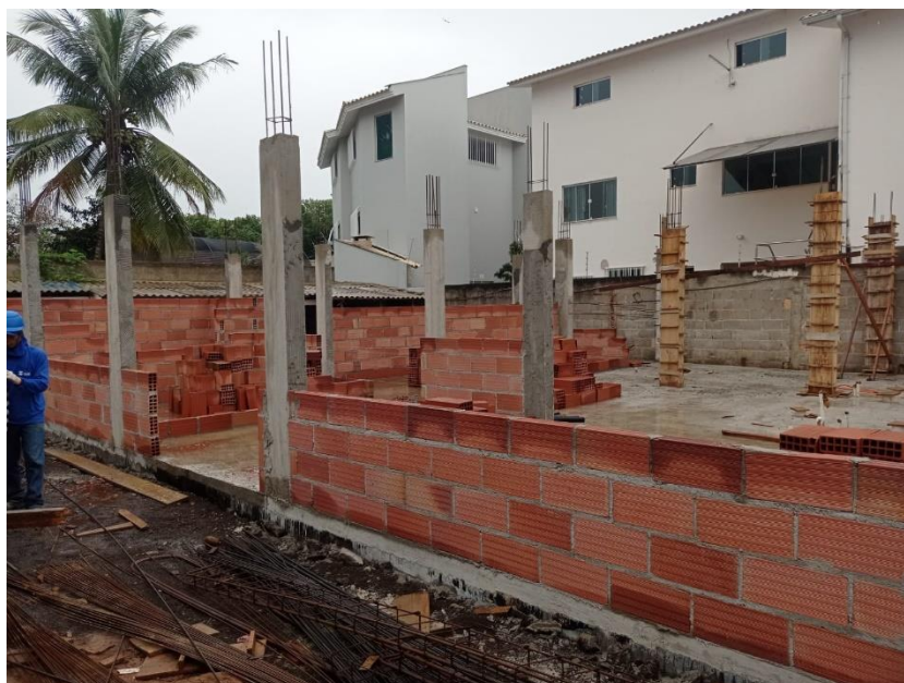
Foto 01: desforma dos pilares
