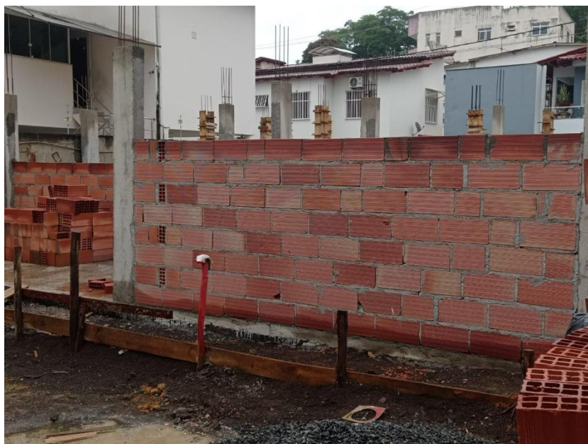
Foto 03: reaterro tubulação externa
