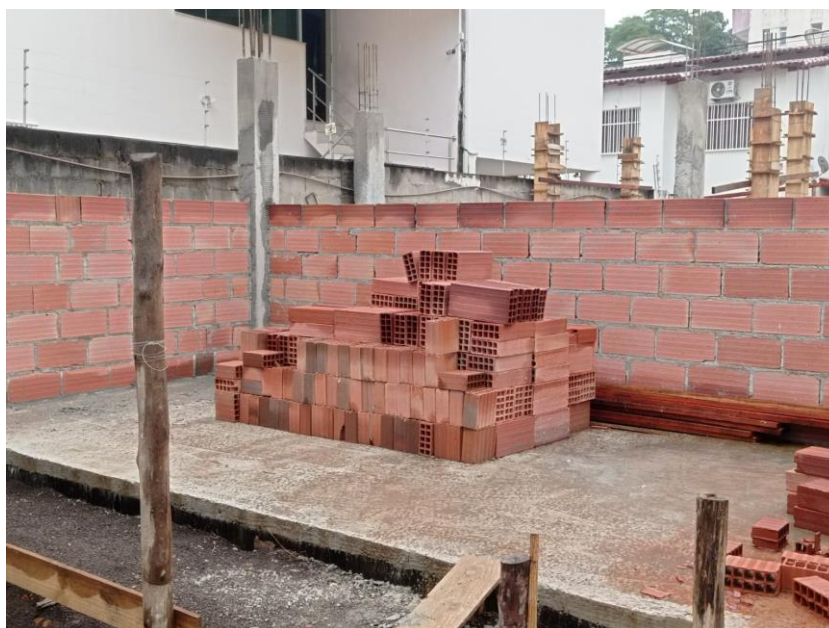
Foto 04: fechamento em alvenaria
