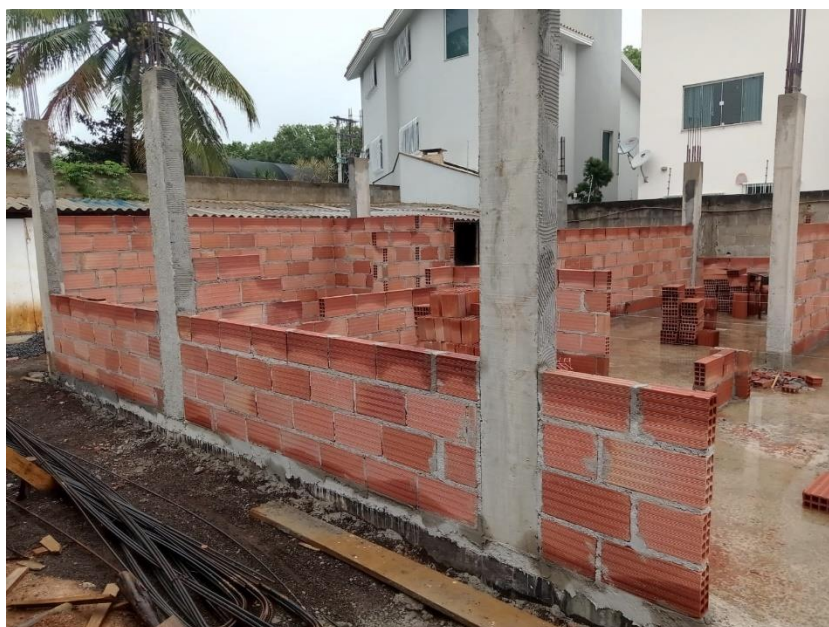
Foto 02: execução de alvenaria
