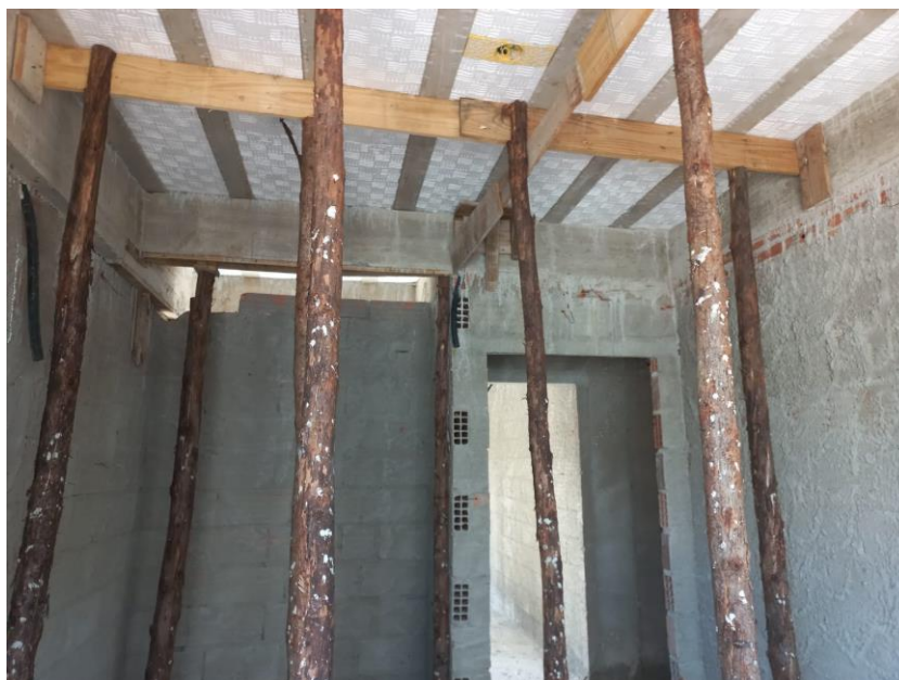
Foto 01: escoramento de laje
