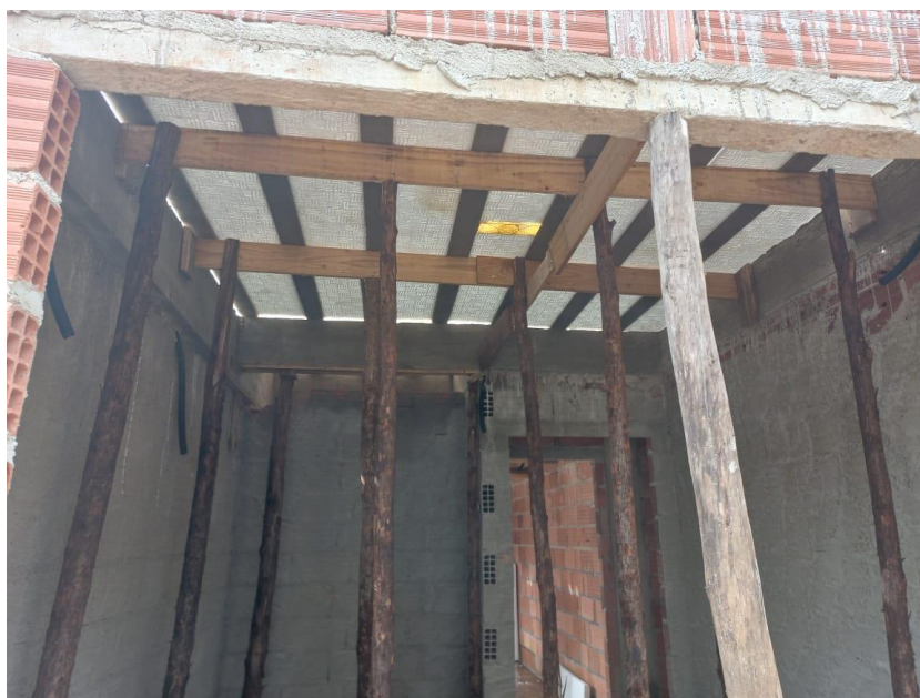
Foto 06: escoramento de laje
