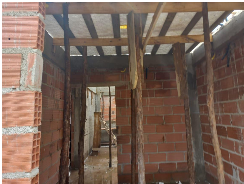
Foto 07: concretagem de laje
