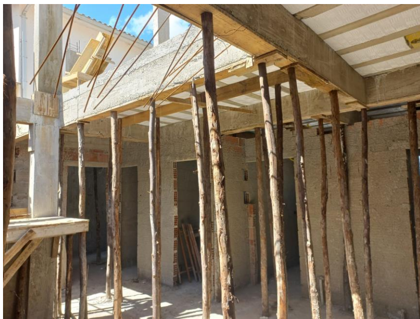
Foto 03: escoramento de laje
