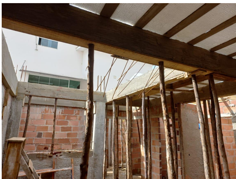
Foto 08: desforma das vigas
