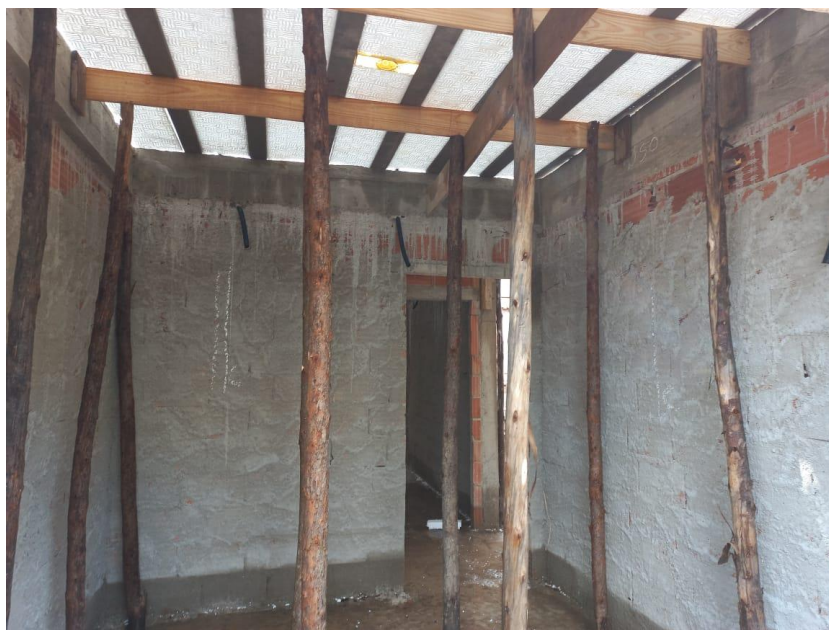
Foto 05: escoramento de laje
