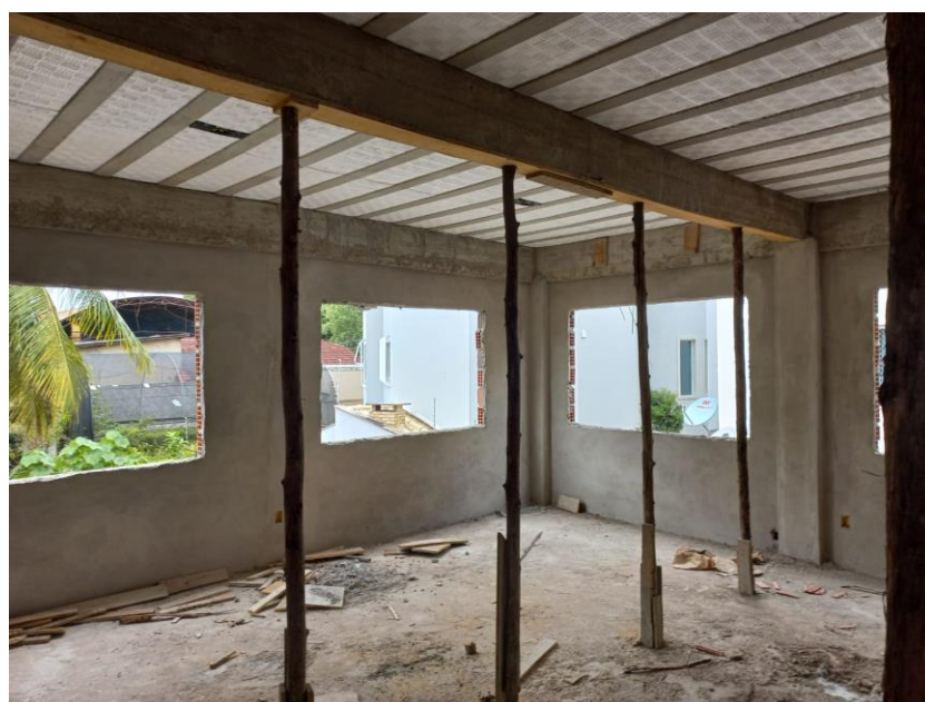
Foto 06: reboco interno
