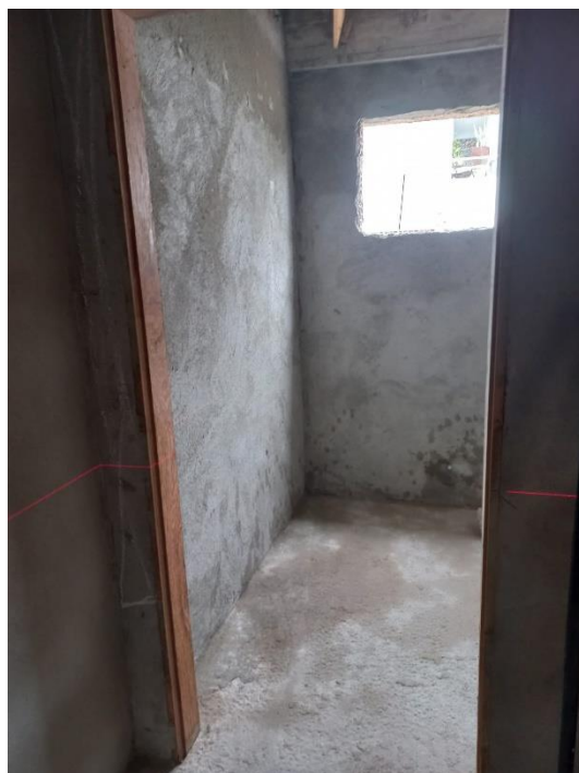
Foto 05: reboco interno
