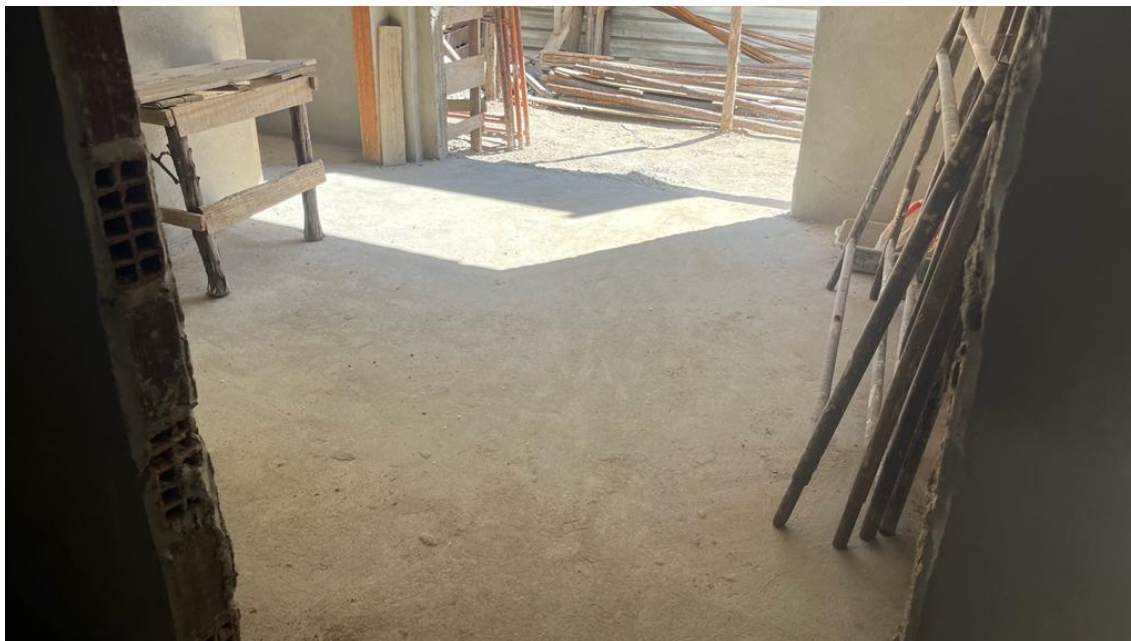
Foto 05: Regularização do piso
