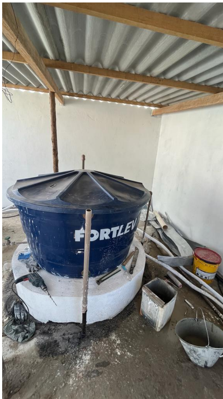
Foto 07: Pintura e Cobertura em fibrocimento
