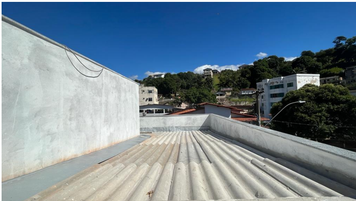
Foto 03: Pintura e Cobertura em fibrocimento
