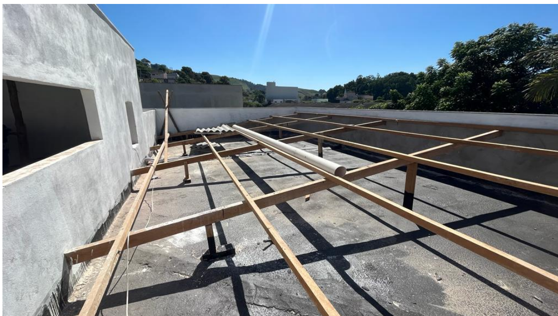
Foto 01: Estrutura de madeira do telhado e pintura
