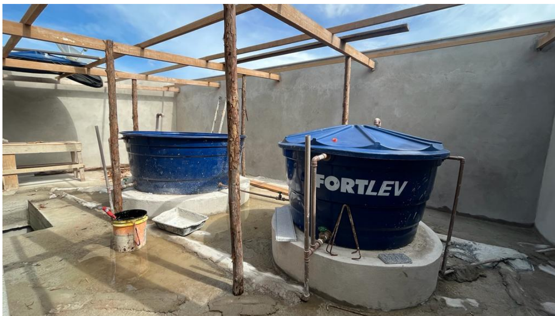
Foto 02: Estrutura de madeira do telhado
