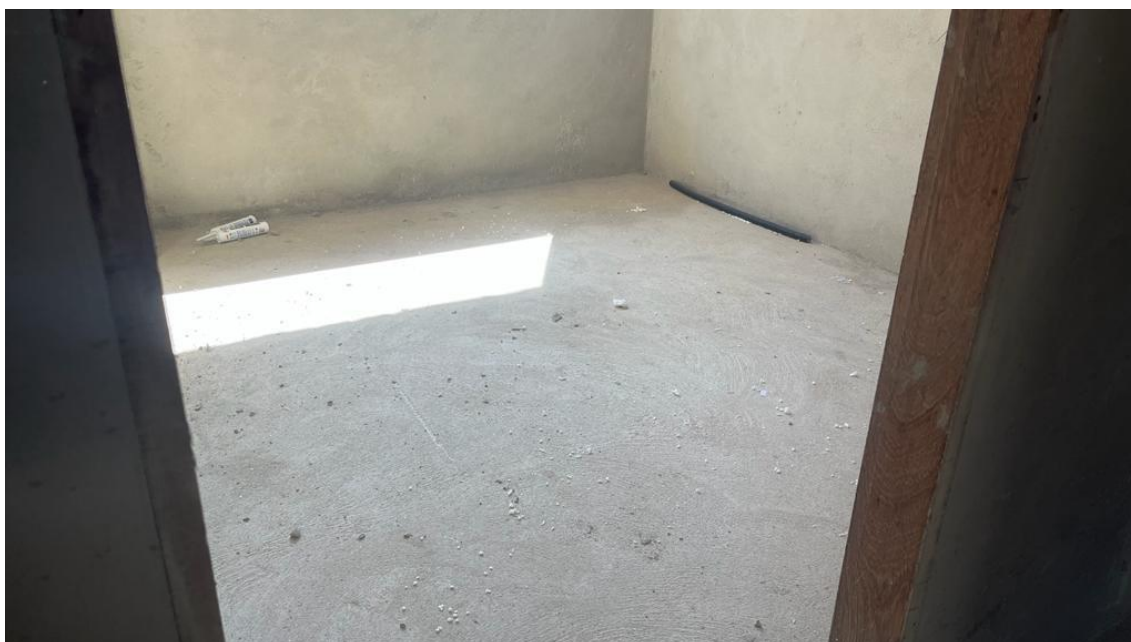
Foto 04: Regularização do piso
