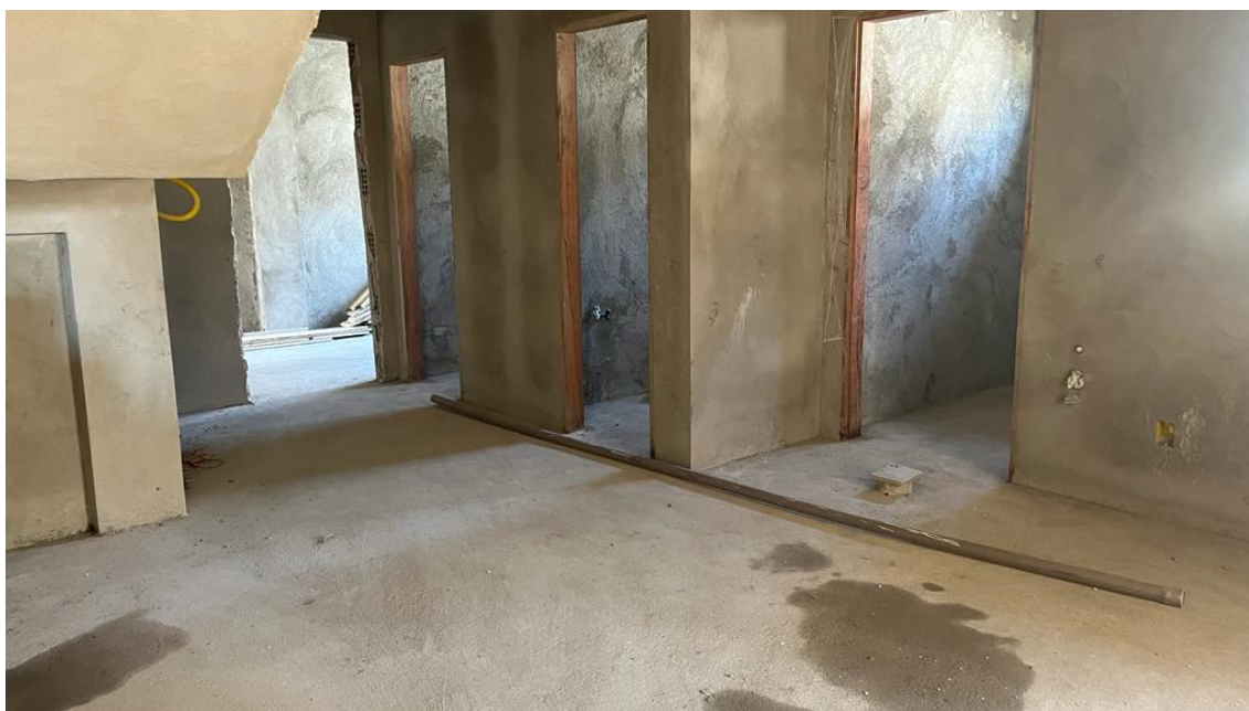
Foto 06: Regularização do piso
