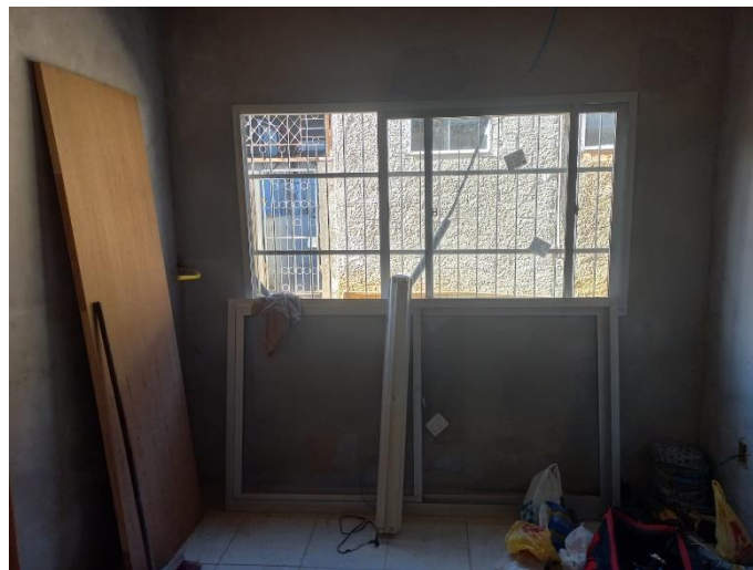
Imagem 05: Instalação de janela
