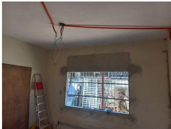
Imagem 07: Instalação de janela
