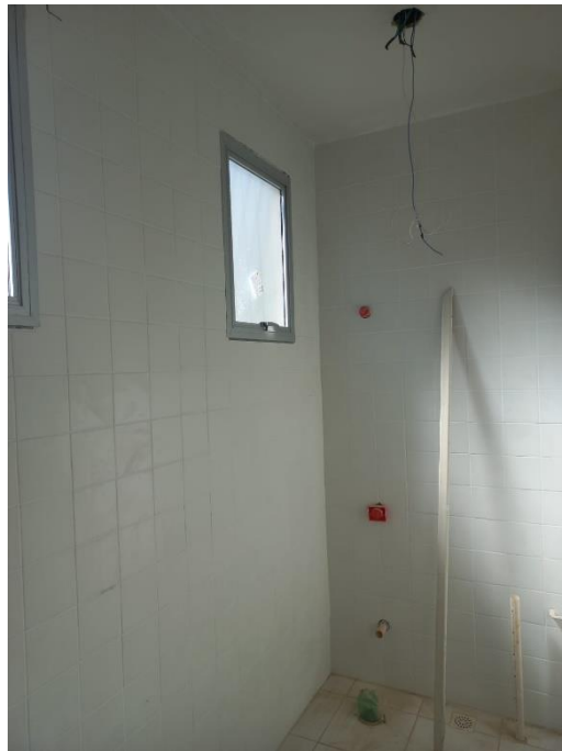
Imagem 05: Instalação de azulejos
