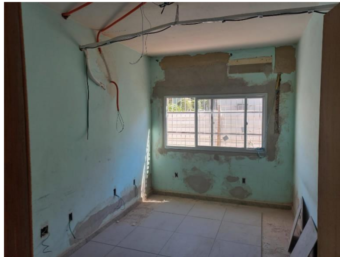
Imagem 06: Instalação de janela
