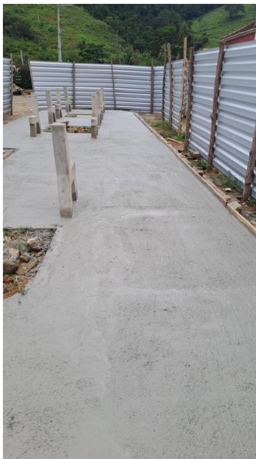
Foto 06: execução de granilite
