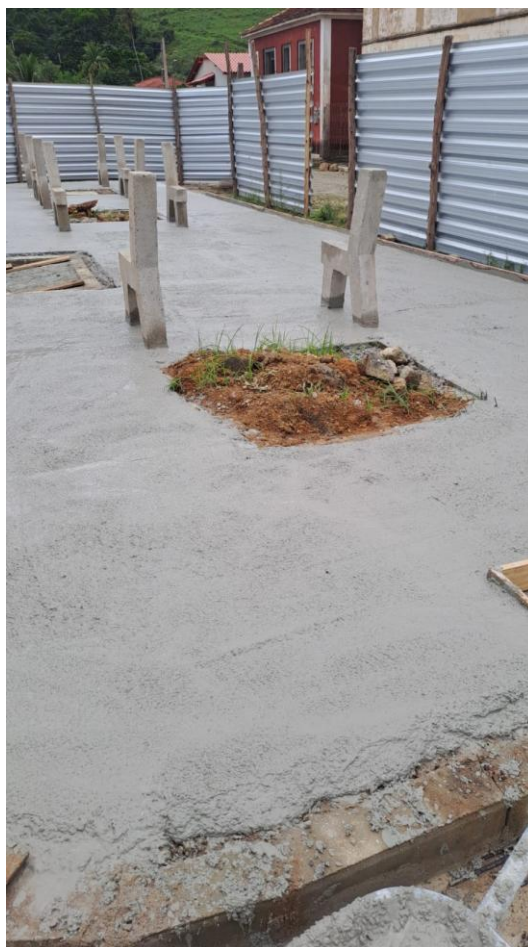
Foto 07: execução de granilite
