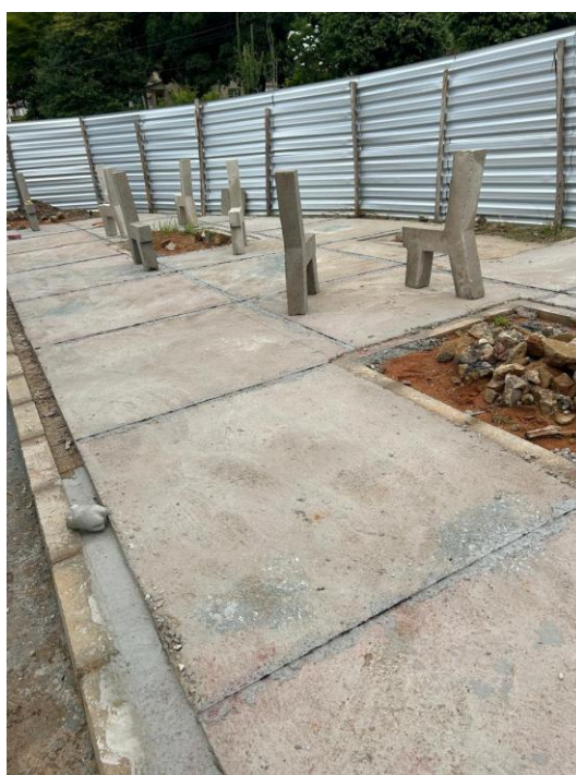
Foto 04: execução de granilite
