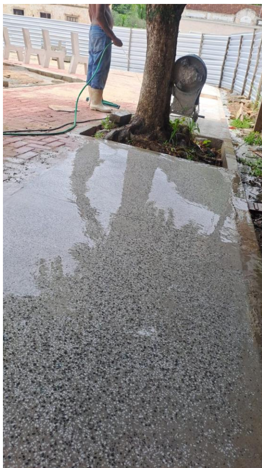
Foto 08: execução de granilite
