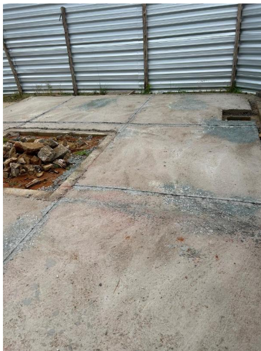
Foto 05: execução de granilite
