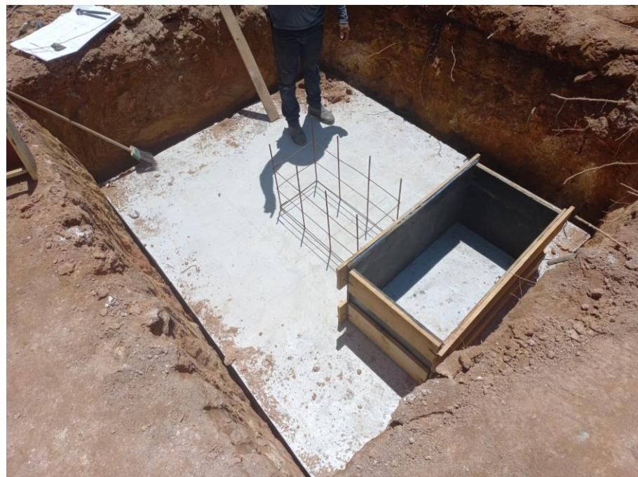
Fotos 03: instalação dos arranques
