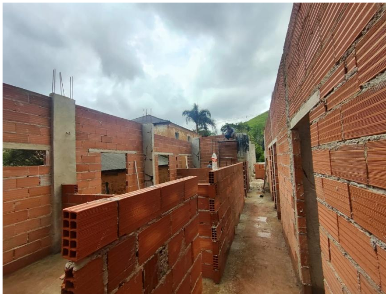
Foto 03: colunas e alvenaria
