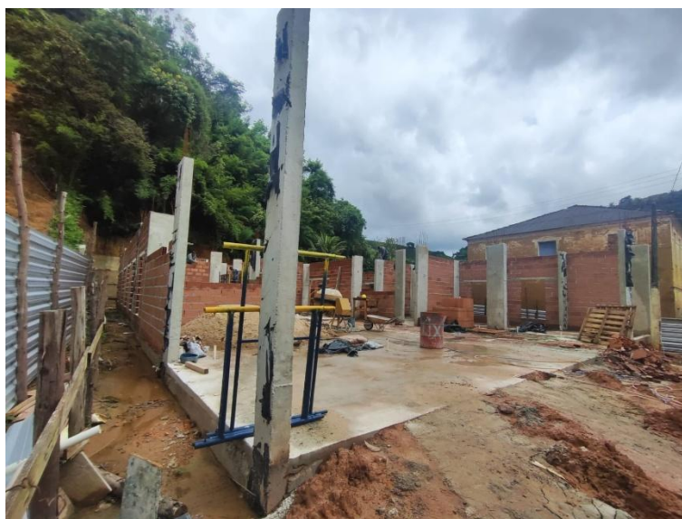
Foto 01: colunas e alvenaria
