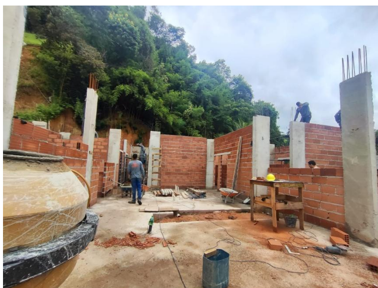
Foto 02: colunas e alvenaria
