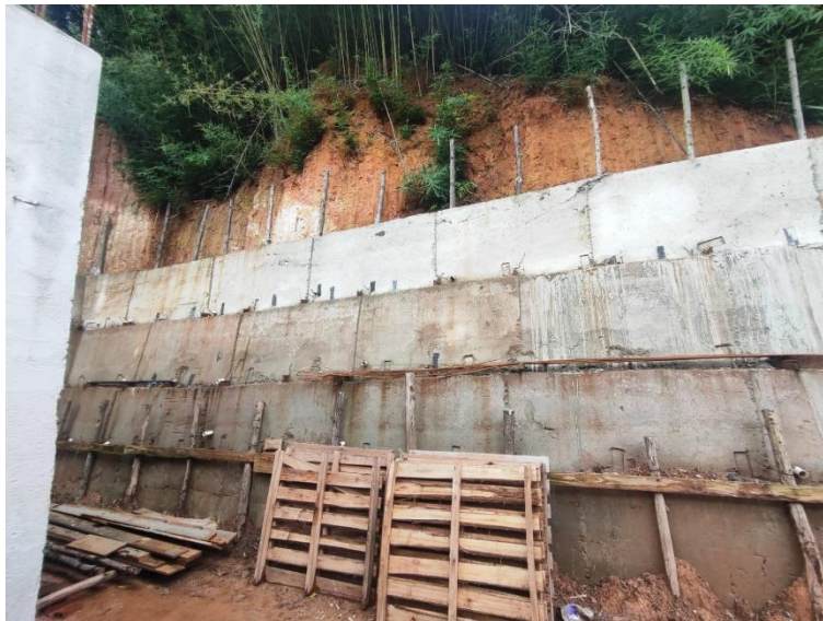
Foto 04: muro de contenção
