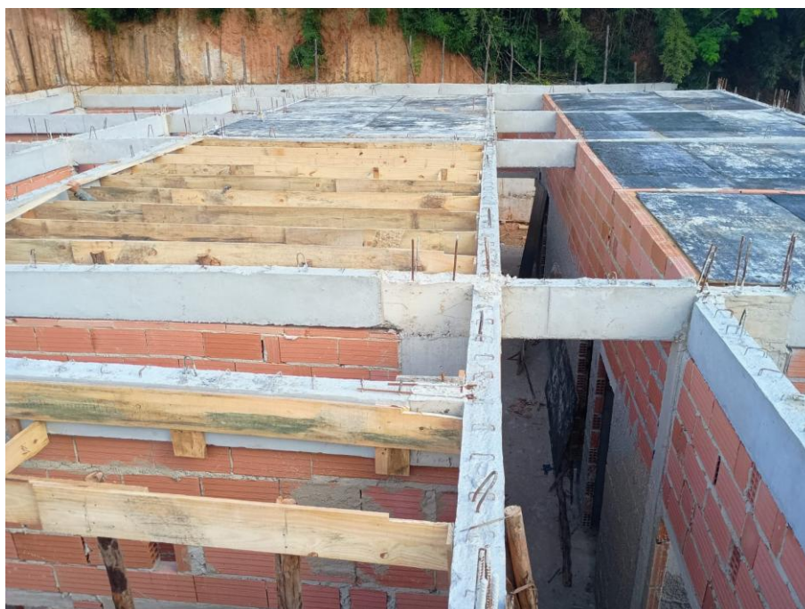
Foto 02: Vigas de cobertura e formas
