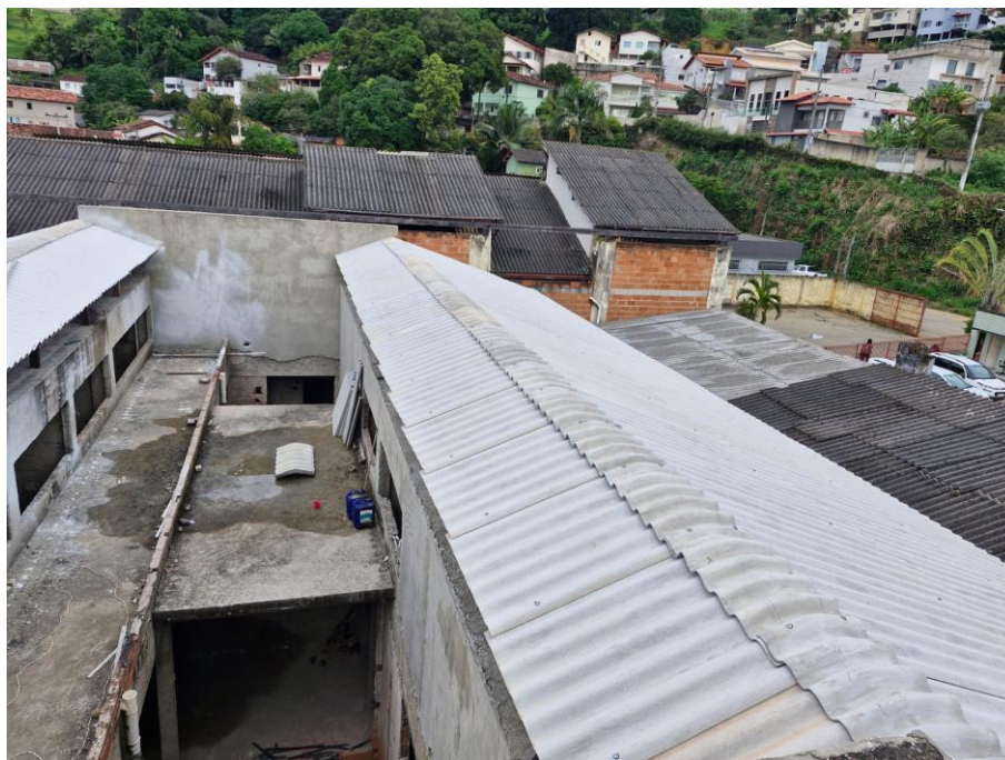
Foto 01: instalação de cobertura
