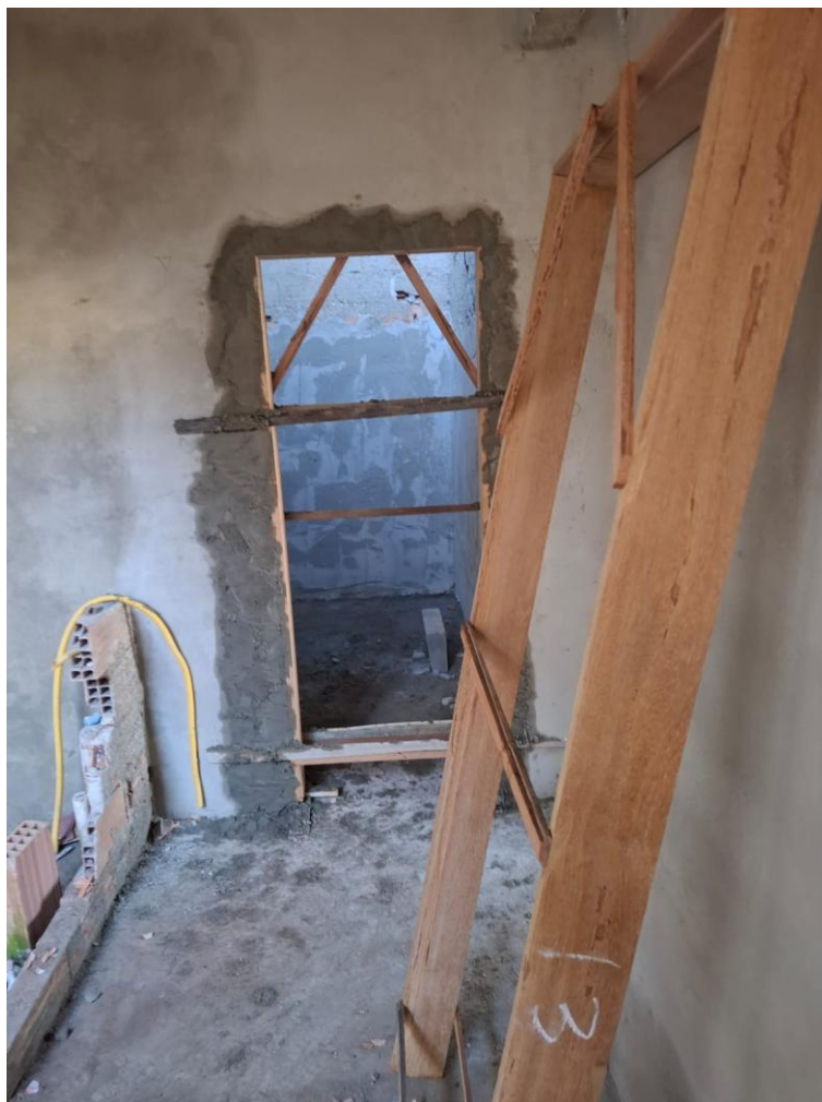
Foto 05: instalação de marco
