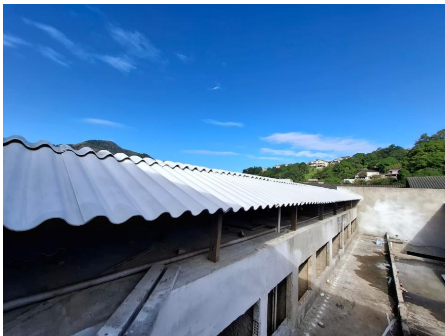
Foto 04: instalação de cobertura
