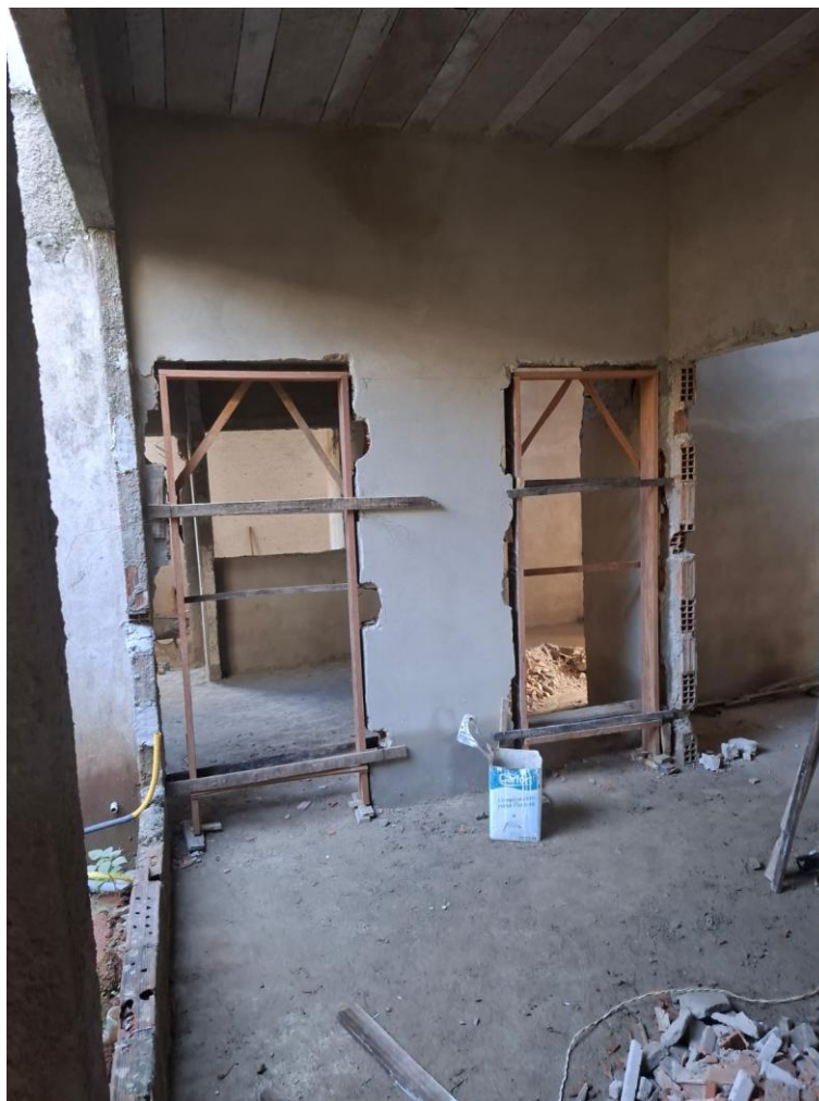
Foto 06: instalação de marco
