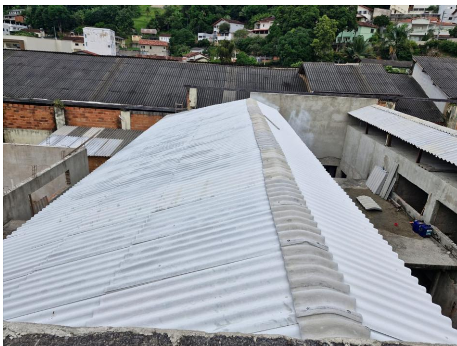
Foto 02: instalação de cobertura
