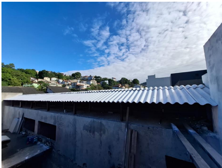
Foto 03: instalação de cobertura
