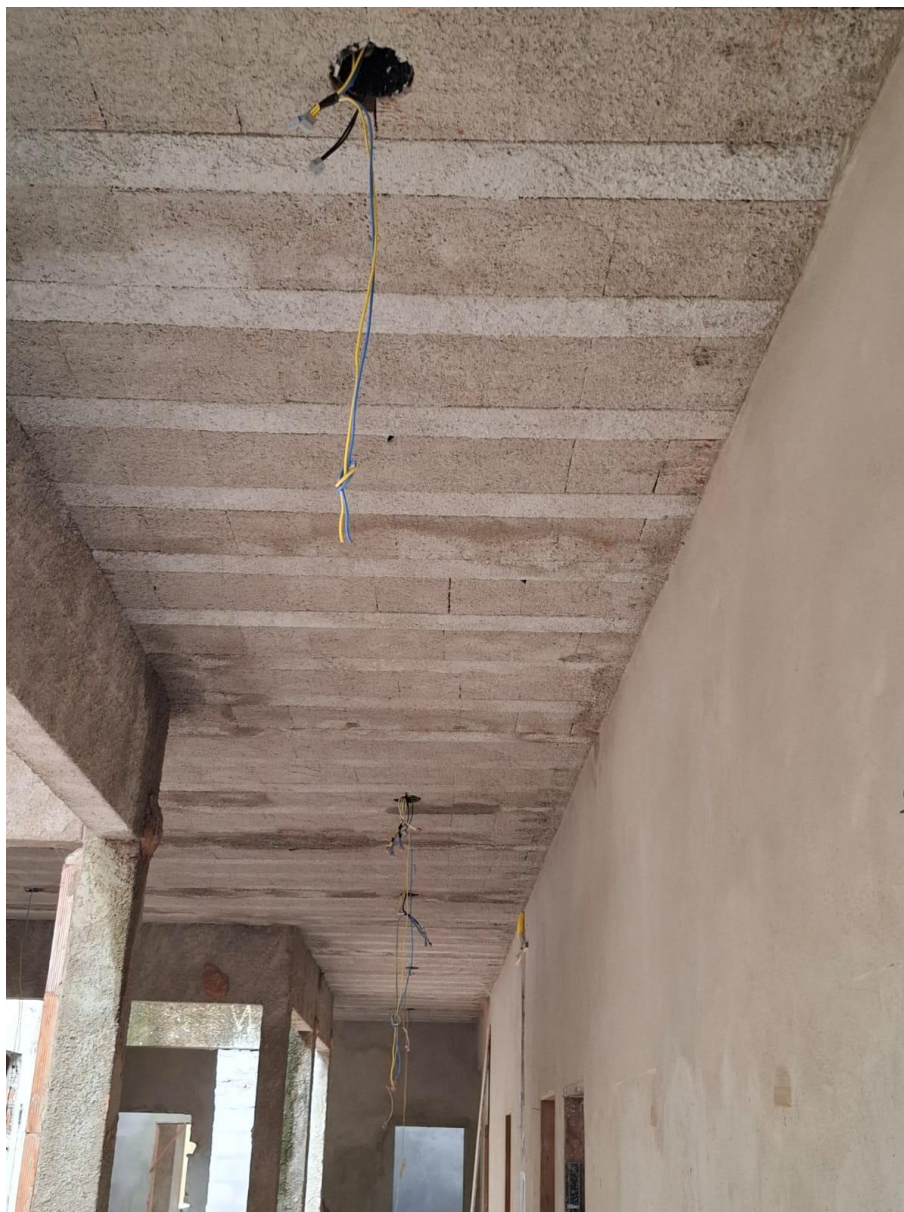
Foto 11: fiação elétrica
