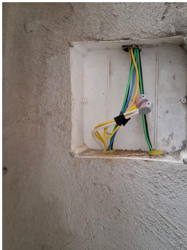
Foto 15: caixa de passagem 4x4
