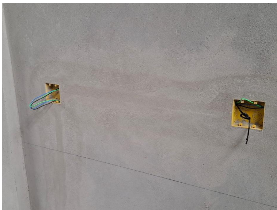
Foto 13: reboco e fiação elétricos
