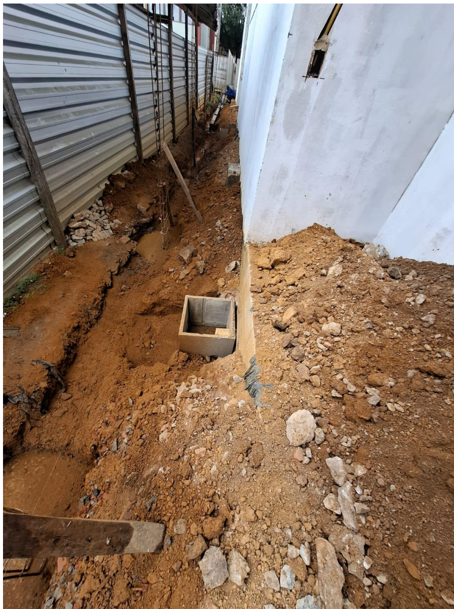
Foto 06: caixa de passagem elétrica
