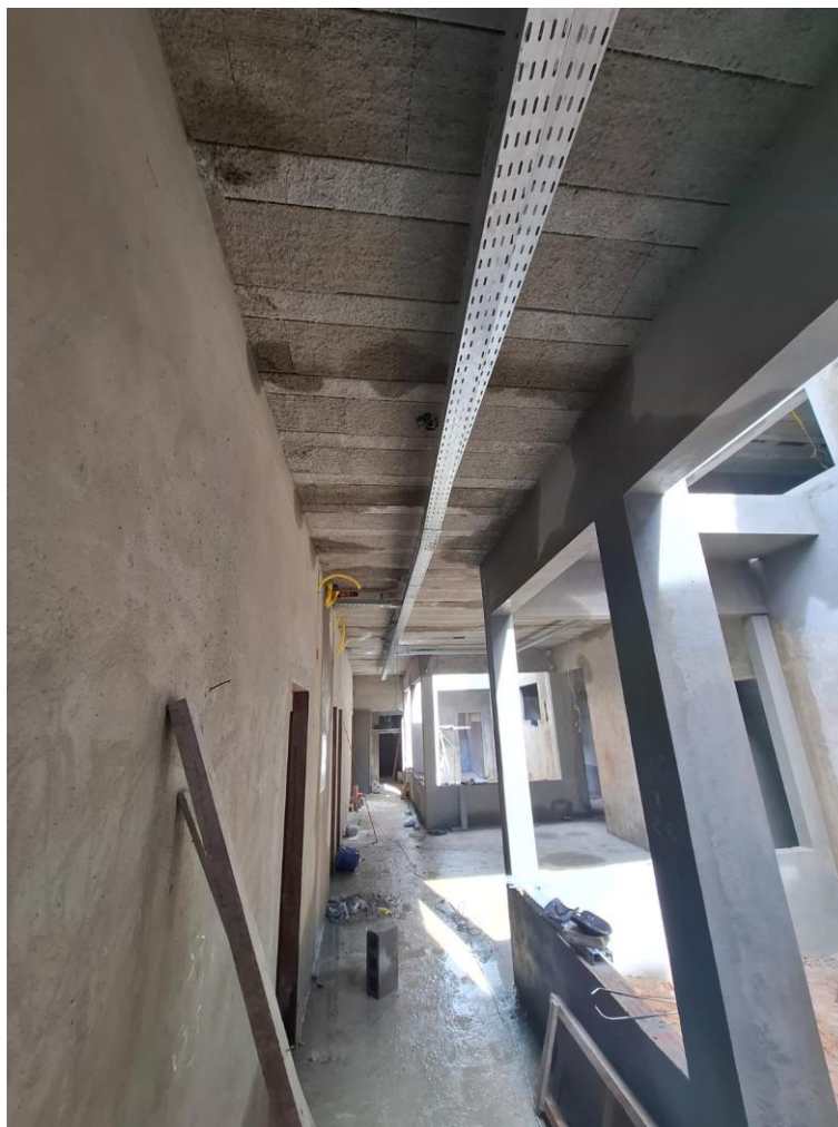
Foto 02: eletrocalha
