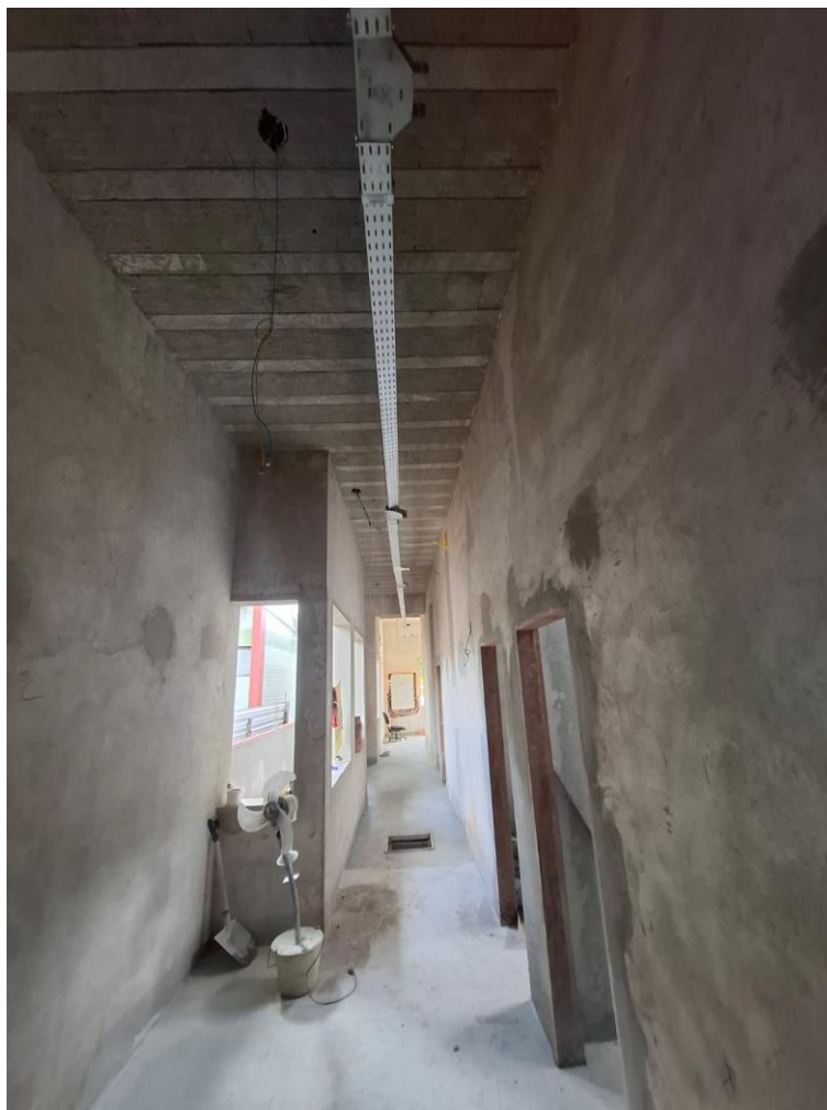
Foto 09: eletrocalha
