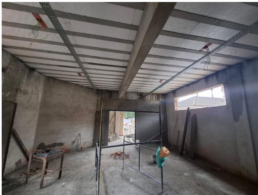
Foto 14: laje pré-moldadas
