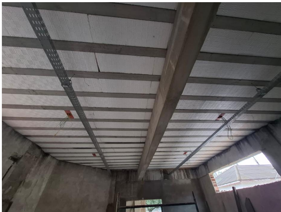
Foto 12: laje pré-moldadas
