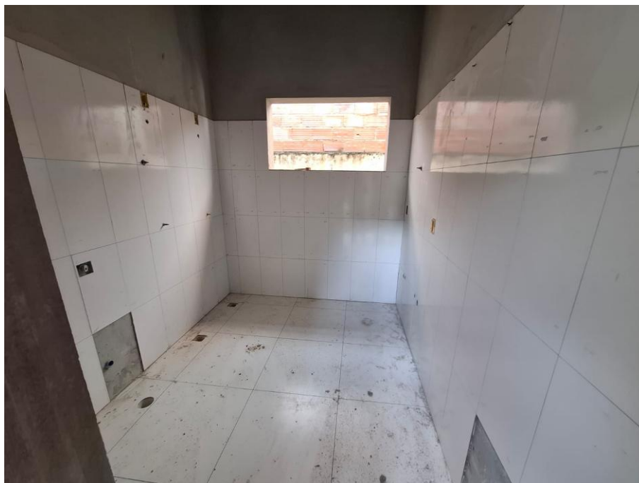
Foto 08: revestimento cerâmico
