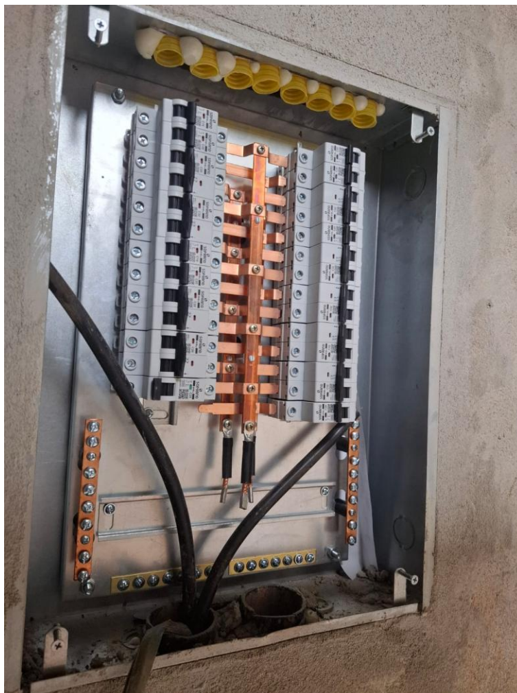
Foto 18: quadro de distribuição elétrico
