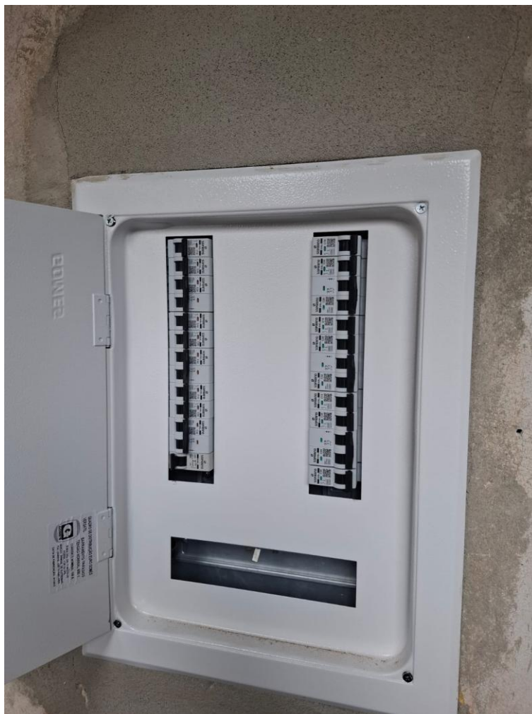
Foto 16: quadro de distribuição elétrico
