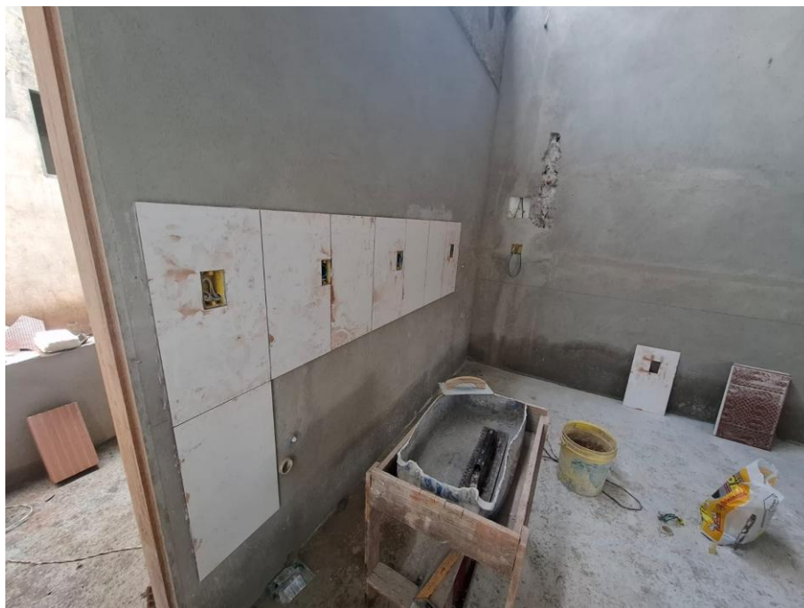
Foto 10: revestimento cerâmico
