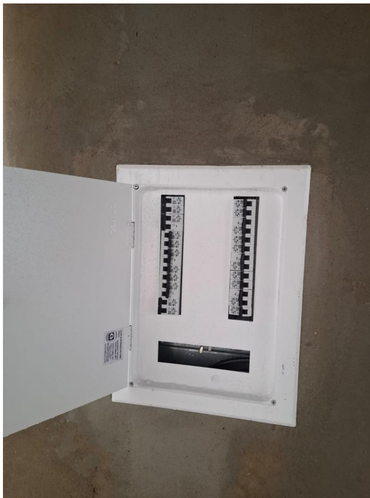
Foto 15: quadro de distribuição elétrico
