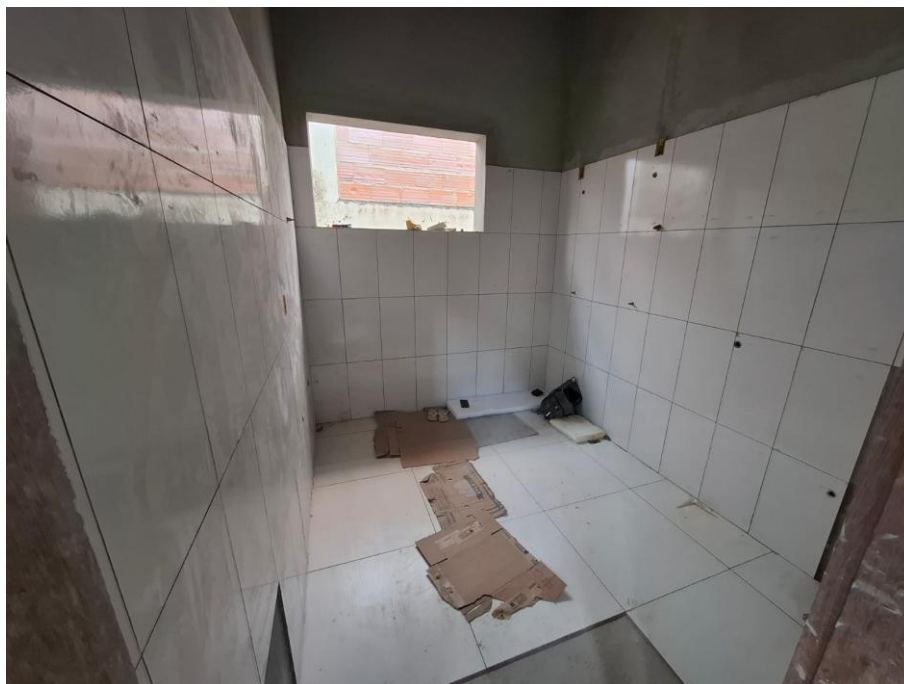
Foto 06: revestimento cerâmico
