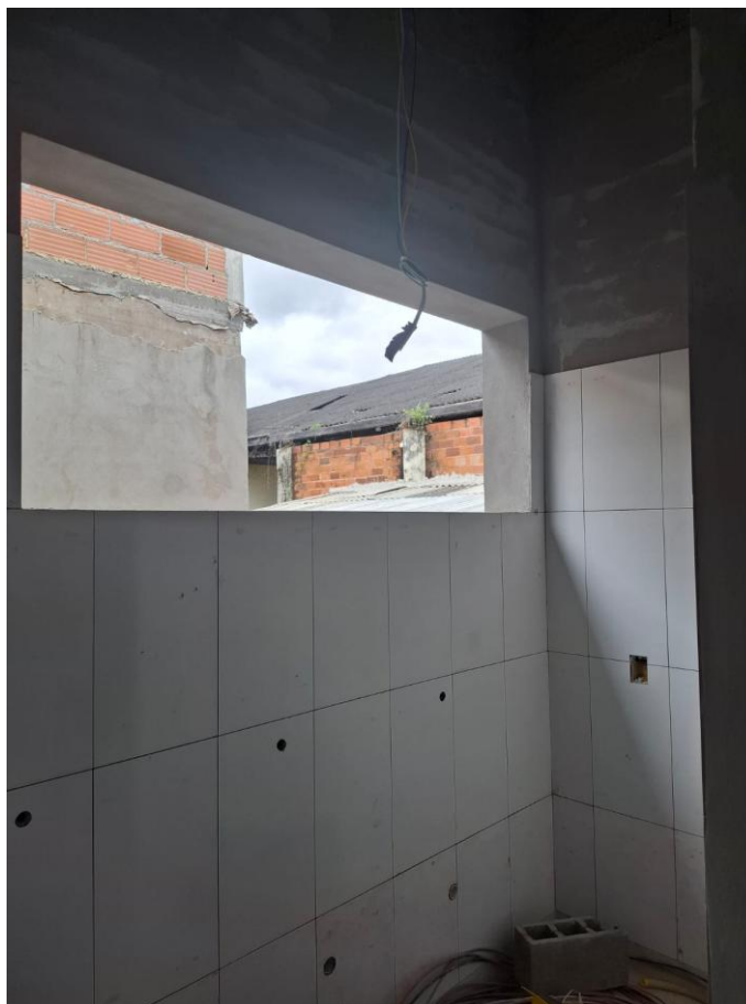
Foto 08: revestimento de parede
