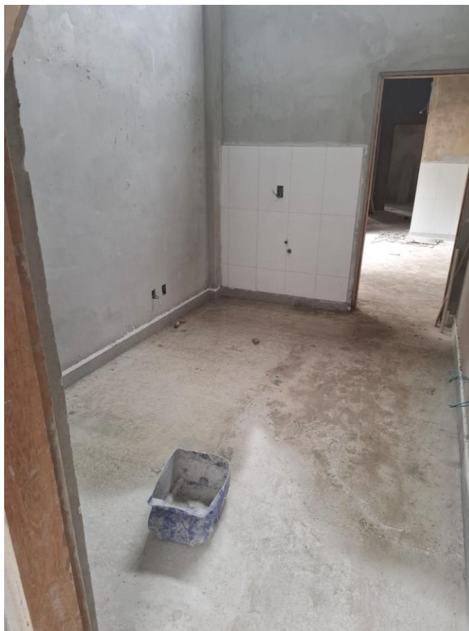
Foto 03: revestimento de parede
