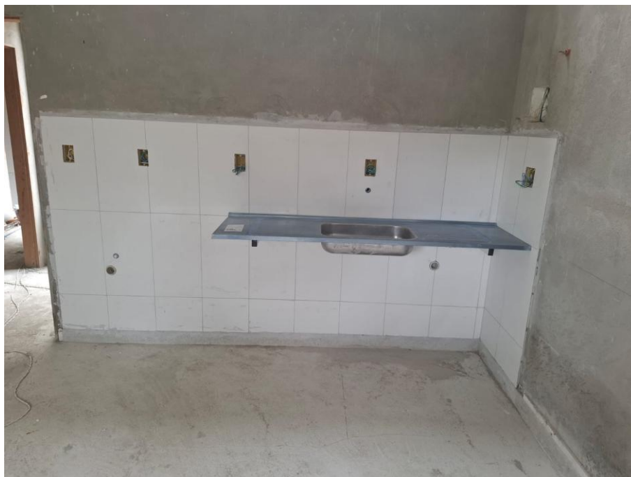
Foto 05: revestimento de parede e pia inox
