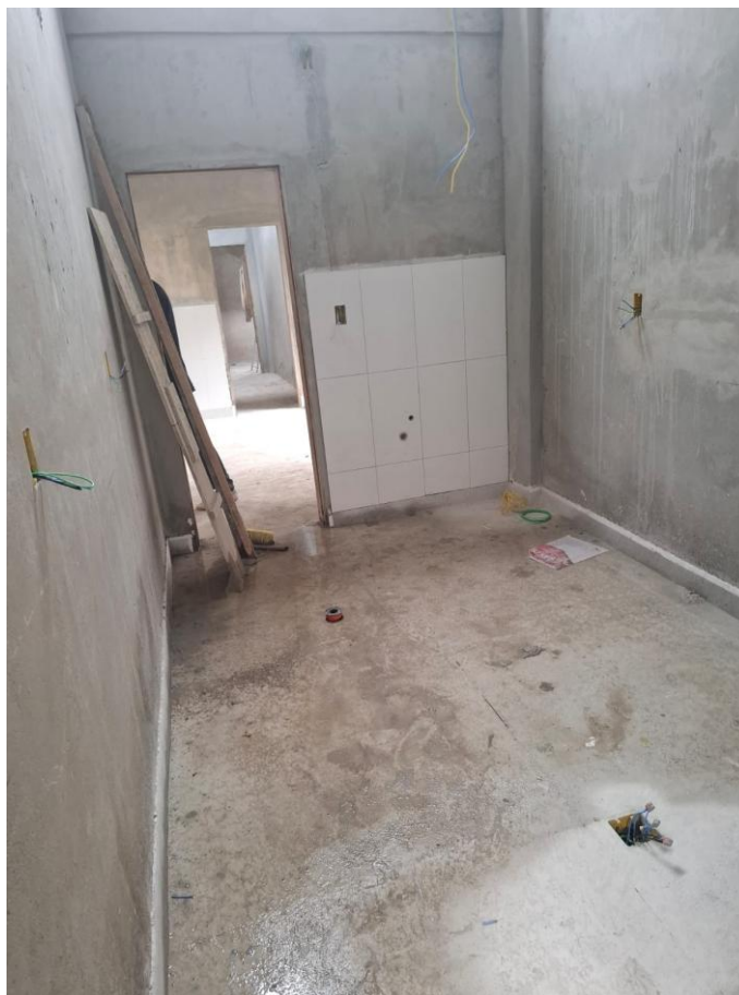
Foto 02: revestimento de parede
