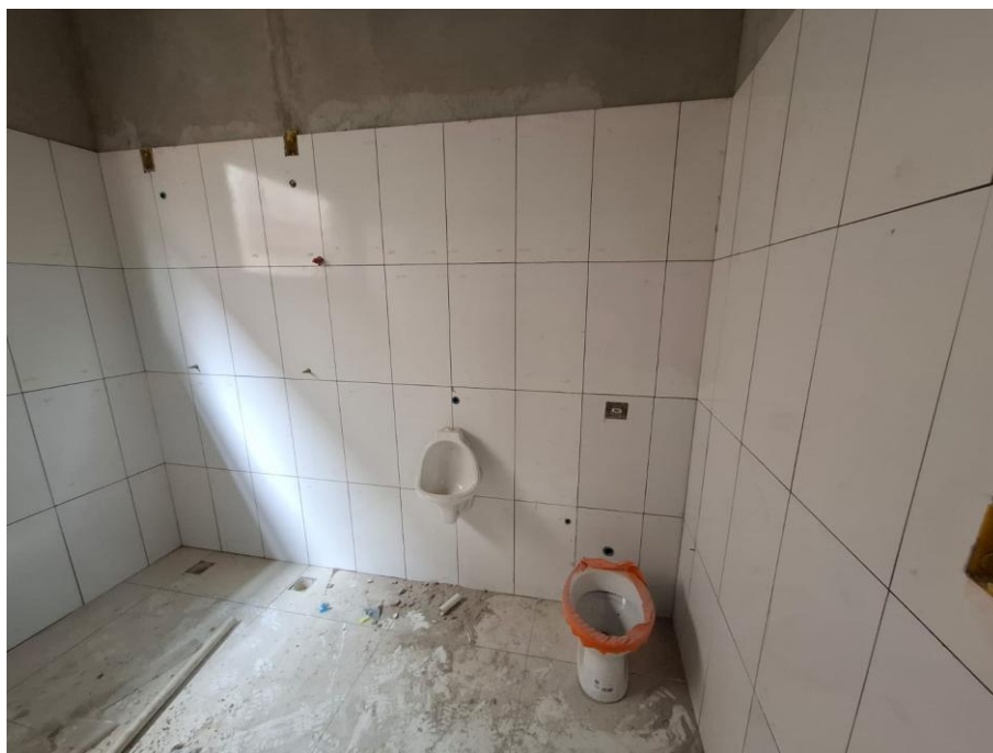
Foto 12: revestimento de parede e louças
