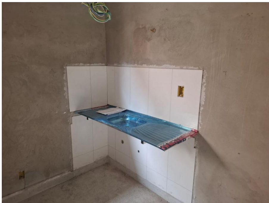
Foto 10: revestimento de parede e pia inox
