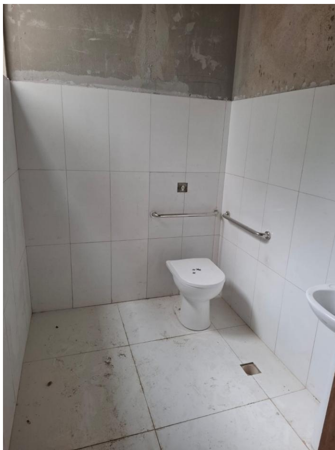
Foto 07: revestimento de parede e louças
