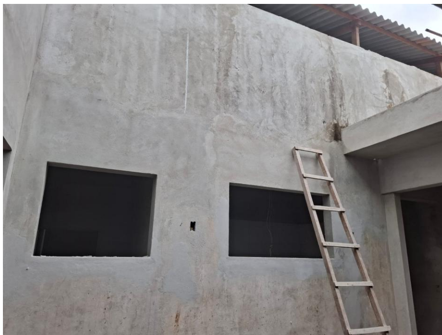
Foto 01: reboco de parede
