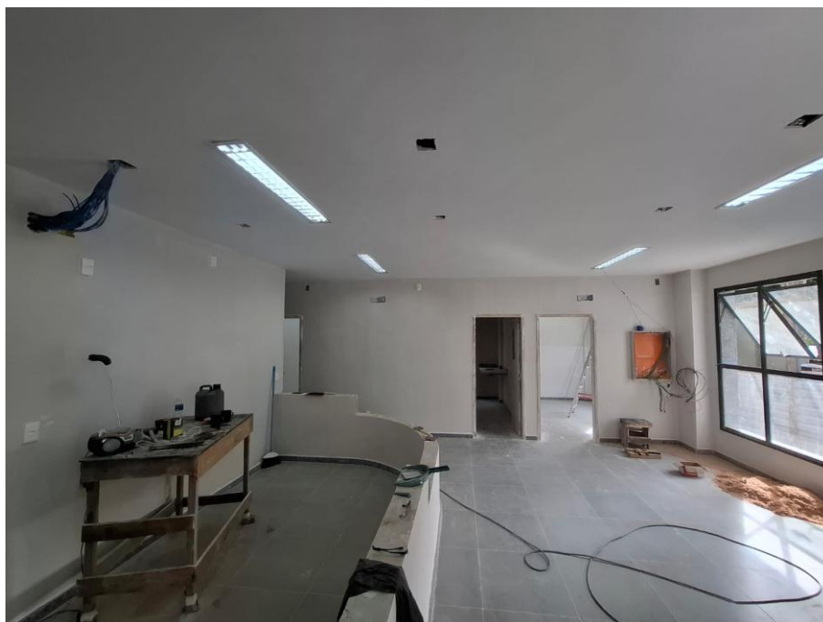
Imagem 10: Emassamento e pintura
