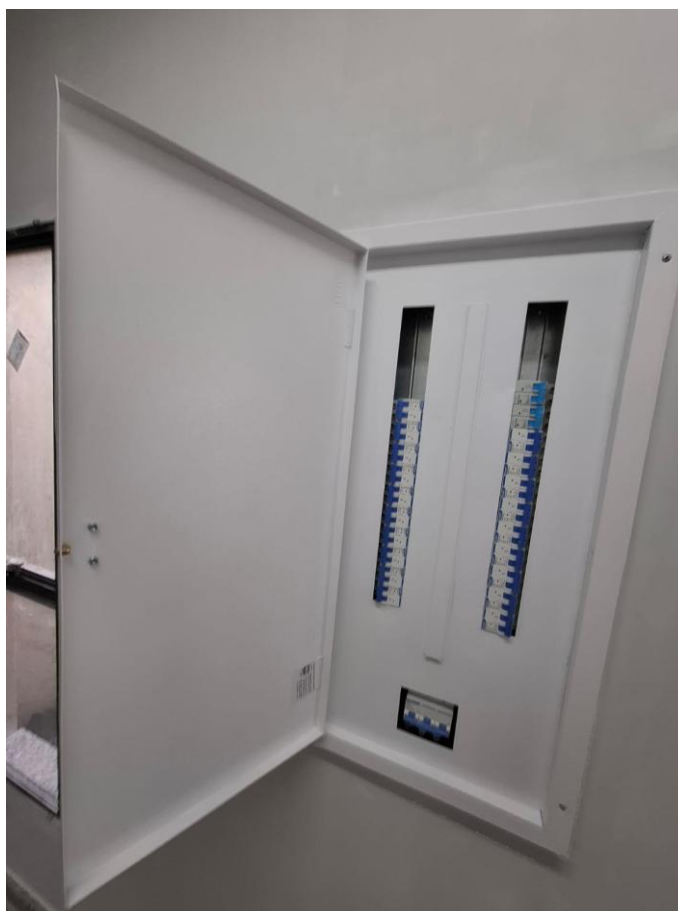
Imagem 01: finalização quadro elétrico
