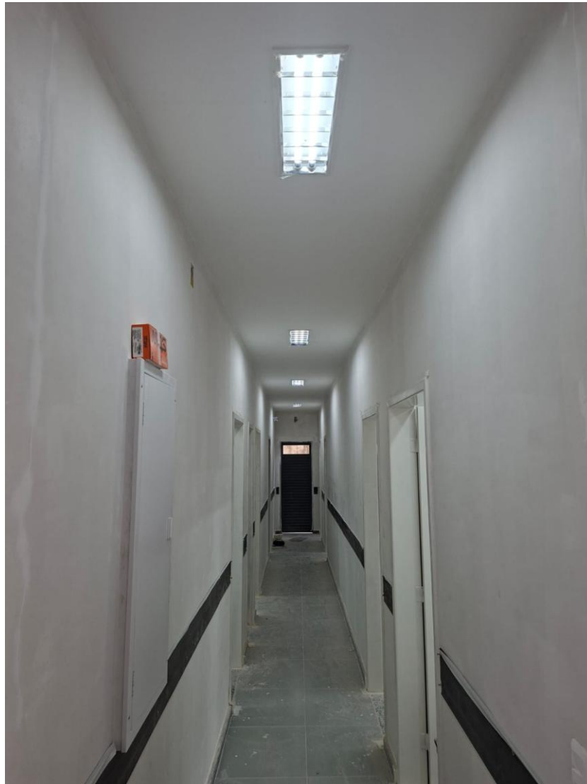
Imagem 07: pintura e emassamento
