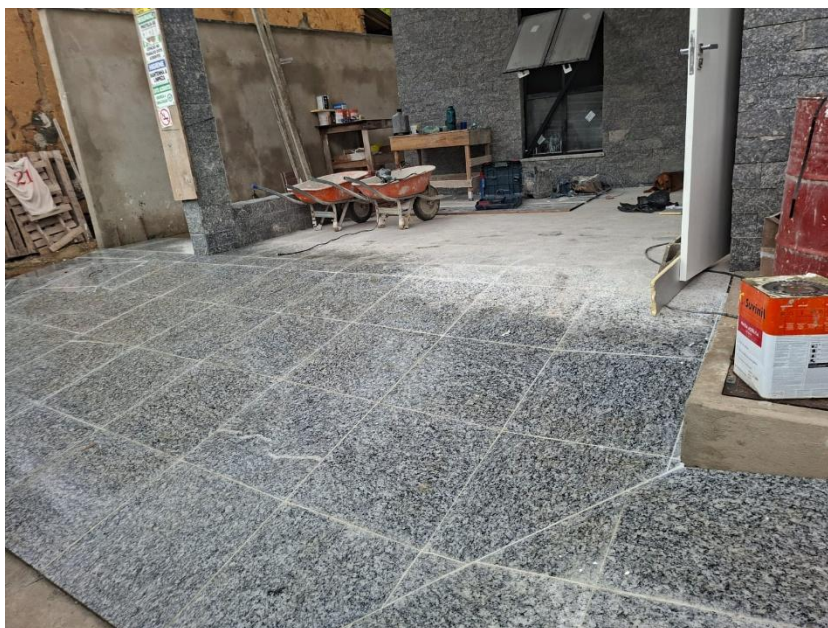
Imagem 08: revestimento de calçada
