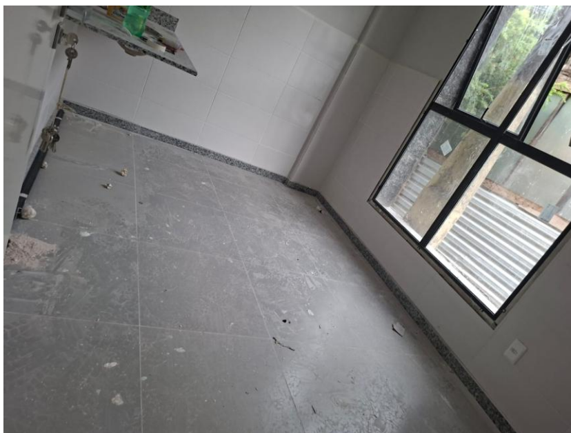
Imagem 05: pintura e emassamento
